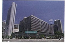
大阪駅前第2ビル
